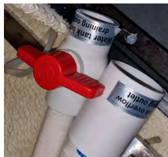
Åbn Servicelåge til afløbshanen og åbn ventilen
